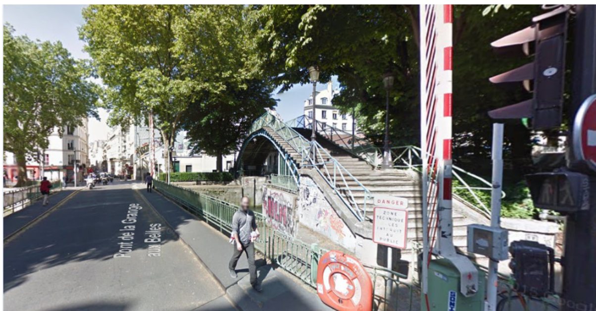
Pont de la Grange aux Belles, Paris
